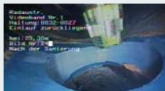
Anschluss im Liner eingebunden
